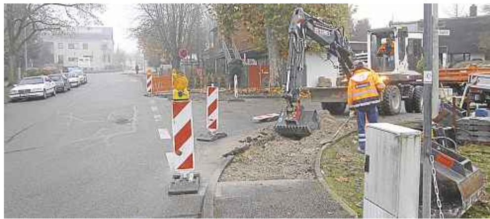
An der Kreuzung Riedstraße/Gaußstraße wurde der Gehweg teilweise erneuert.
