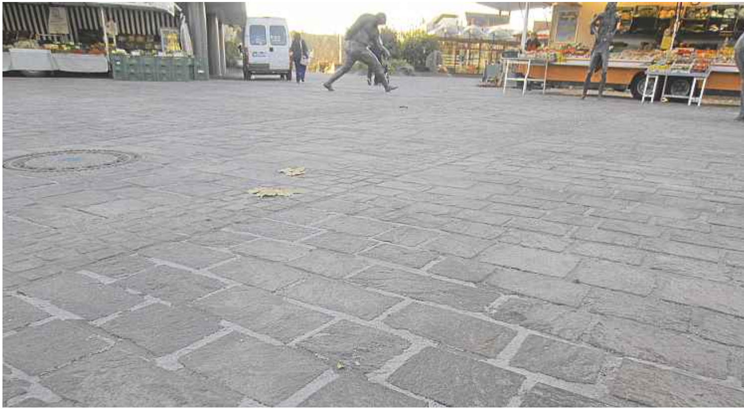
Auf dem Freiburger Marktplatz haben Mitarbeiter des Bauhofs die Pflasterfugen saniert und damit Stolperstellen entfernt.
